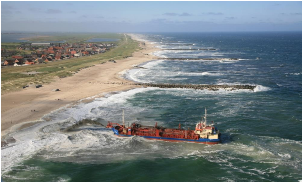
Figura 2-22 Recuperación de la costa mediante vertido por cañón
