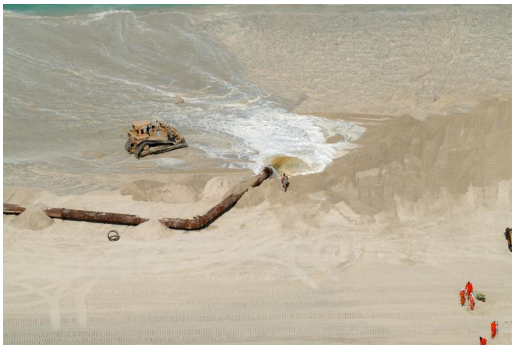
Figura 2-23 Recuperación de la costa mediante tubería
